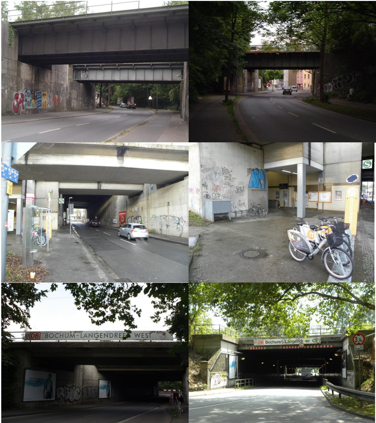
Abbildung 66: Impressionen Bahnunterführungen im Bereich S-Bahnhof Langendreer West (Bild 1-5) und S-Bahnhof Langendreer (Bild 6) (DSK 2015)
